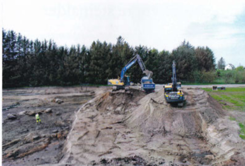
Fig. 4. Totalt vart det fjerna rundt 15 000 m 3 ved utgravinga i Sømmevågen. Avdekkingsarbeidet tok nær tre månader, og det meste av tida var det to gravemaskinar og fleire lastebilar i sving for å få bort massane. Foto: Arkeologisk museum.
