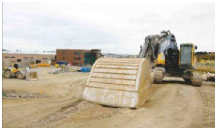
Det sprenges og kjøres vekk masse fra Orshaug hvor arkeologene lå på kne og gravde for noen måneder siden. Terrengnet blir 37 meter lavere når tomten er klargjort for bygging. (Foto: Hilde Garlid)
