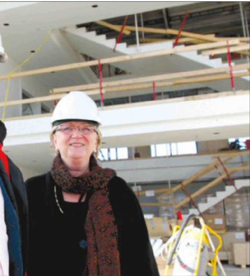
Bygg AS og Inger Lindland i Baker Hughes har jobbet tett sammen med Bygg AS er totalentreprenør, både for tomteklargjøring og for bygging av (Foto: Hilde Garlid)
